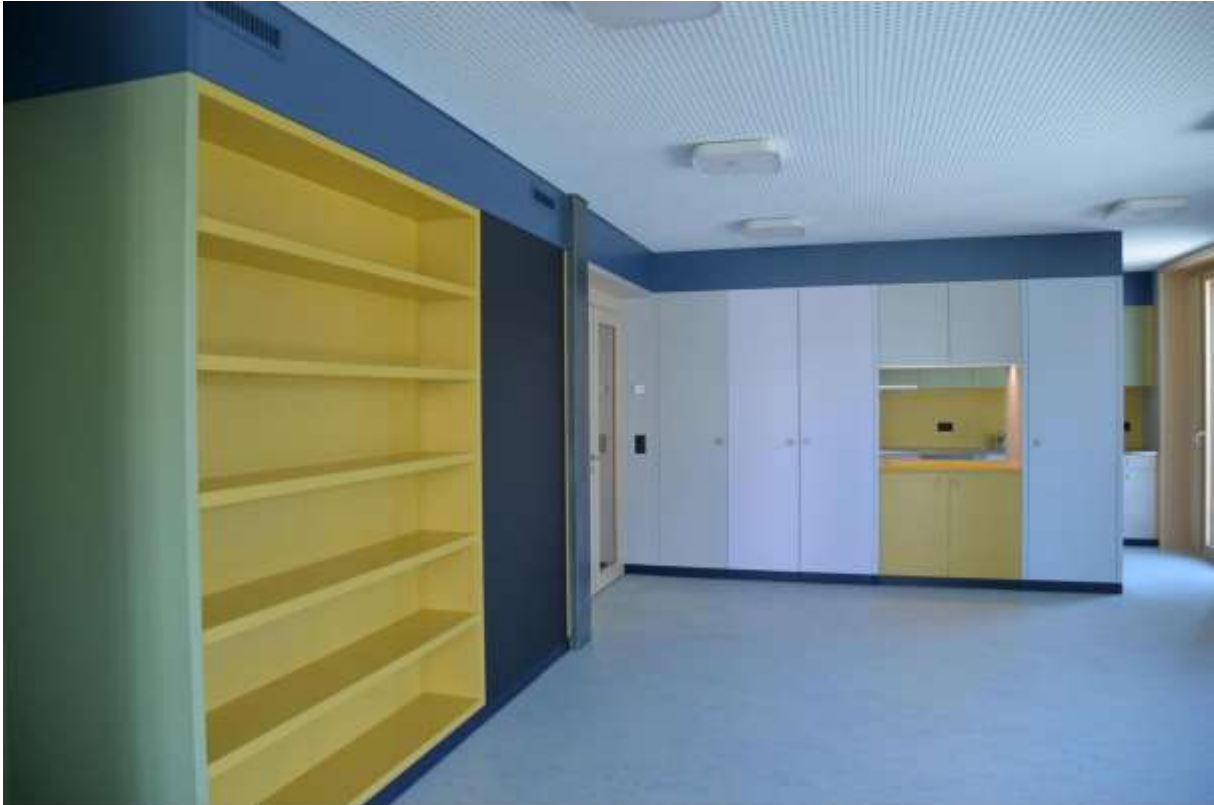
2/4 Der noch nicht ganz fertiggestellte Innenausbau der Tagesstrukturen genannt Tagesstern.
